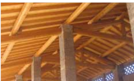
Cascina - roof trusses in „Usò Fiume“ beams
